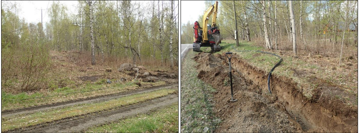
Vasen. Kaapelilinjan reittiä Kuitikas muinaisjäännösalueen läheisyydessä. Itään. Oikea. Kaivettua kaapelioljua Rautakoskentie laidassa Salon kartano 1 kohdalla. Itään.
