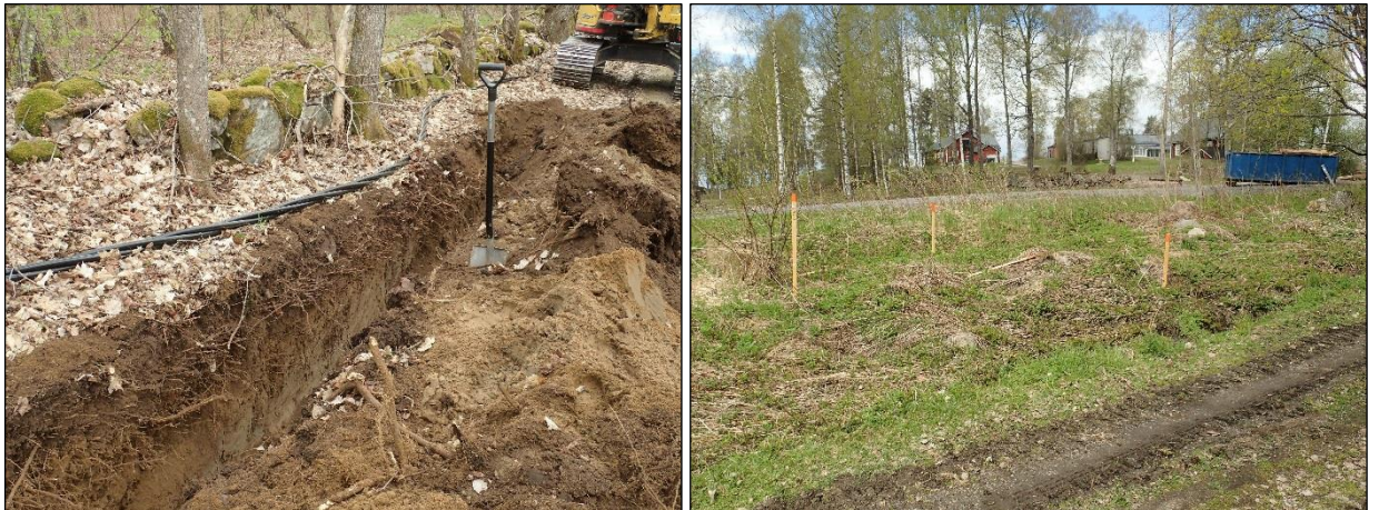
Kaivettua kaapelilinjaa Kuitikas - nimisen muinaisjäännösalueen koillispuolella. Lounaaseen. Oikea. Muuntamon paikka.
